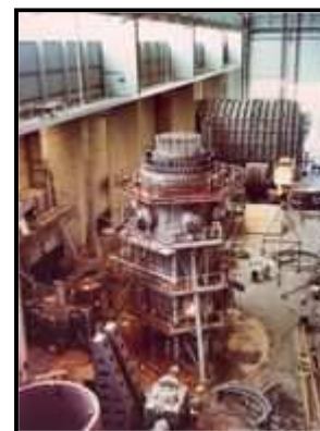
Kolos van reactorvat in opbouw, 1970
