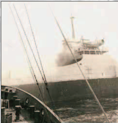
Meteen nadat de Holland bij de Olympic Thunder aankomt wordt begonnen met het blussen van de brand.
