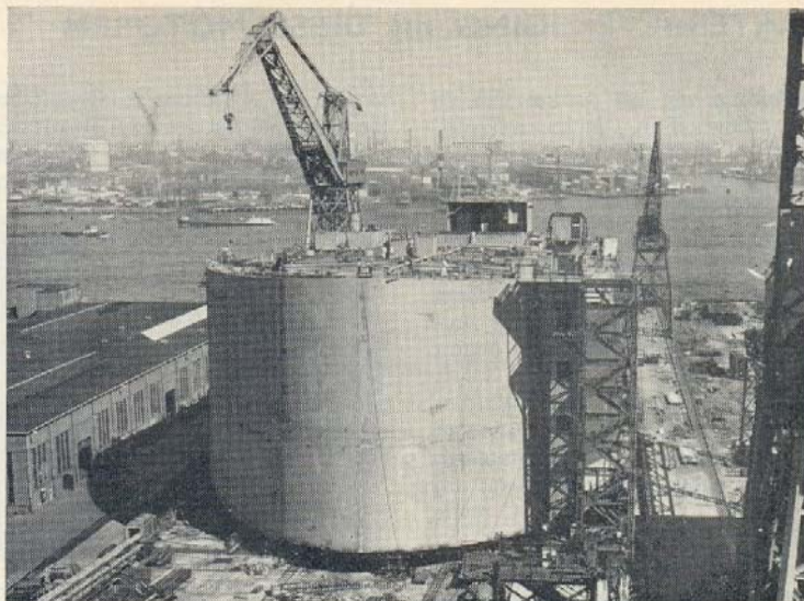
Een vooraanzicht van het door de RDM gebouwde gedeelte van het opslagschip voor ruwe olie. Het op helling 8 gebouwde gevaarte torent hoog uit boven de werkplaatsen in de naaste omgeving.
