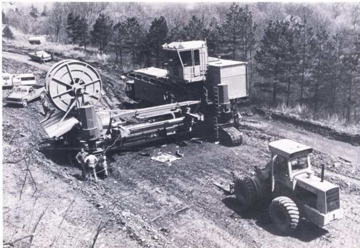
De door RSV zelf ontwikkelde kolengraafmachine op een bank in West-Virginia (USA) opgesteld.
